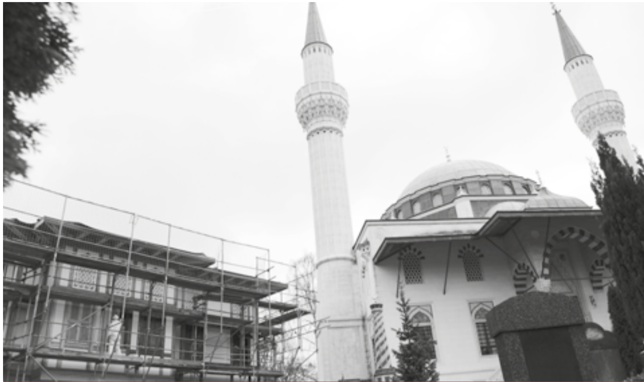
Bei der Arbeit: Der Anbau neben der Moschee soll nach Fertigstellung auch Ort der Begegnung für den Schillerkiez werden
